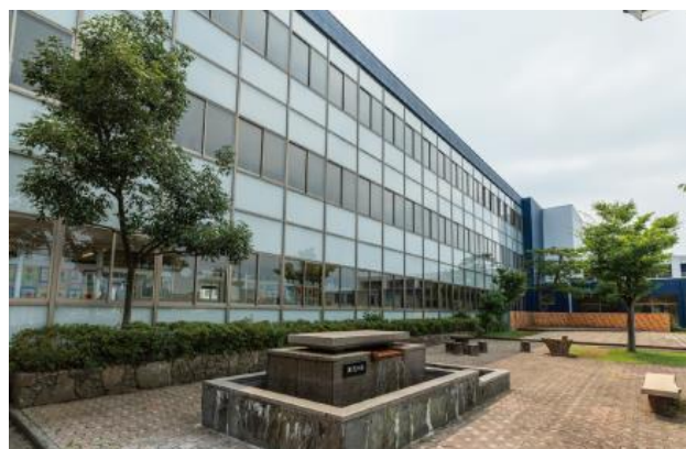
鷹施・高志野統合中学校校舎棟 大規模改造第2期工事 (建築主体)
