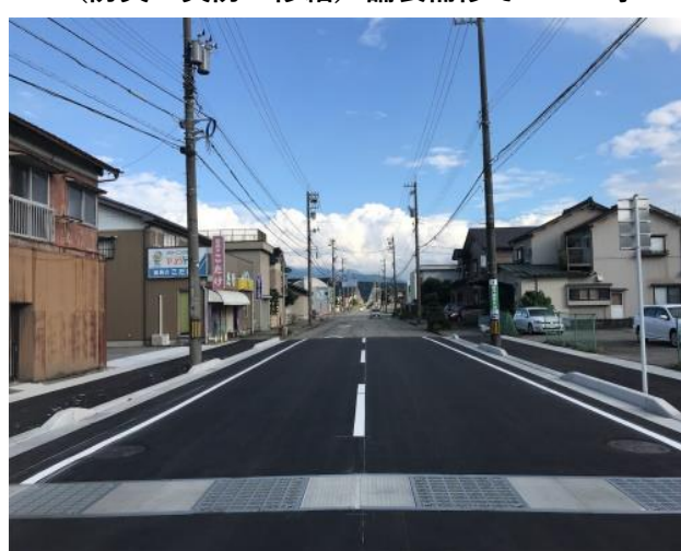
市道前沢大布施線舗装工事
