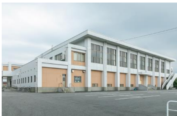
高志野中学校体育館新築工事
