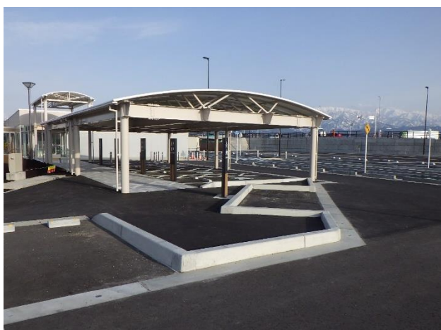
道の駅「(仮称)くろべ」駐車場整備 その2工事
