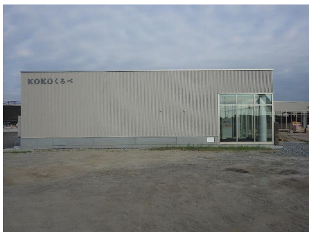
道の駅「(仮称)くるべ」地域振興施設新築工事 (建築主体)
