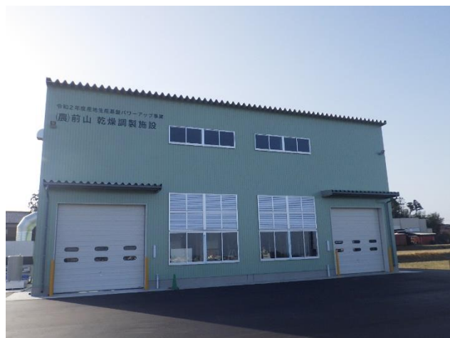
農事組合法人前山 乾燥調製施設新築工事
