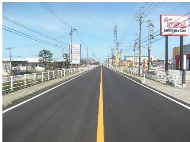
一般県道魚津入善線道路総合交付金 (防災・災防・修繕) 舗装補修その3工事
