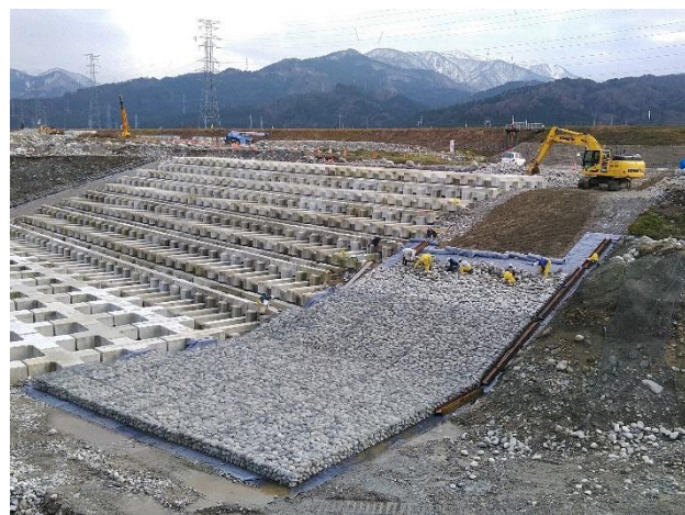
令和2年度下立縦工その2工事
