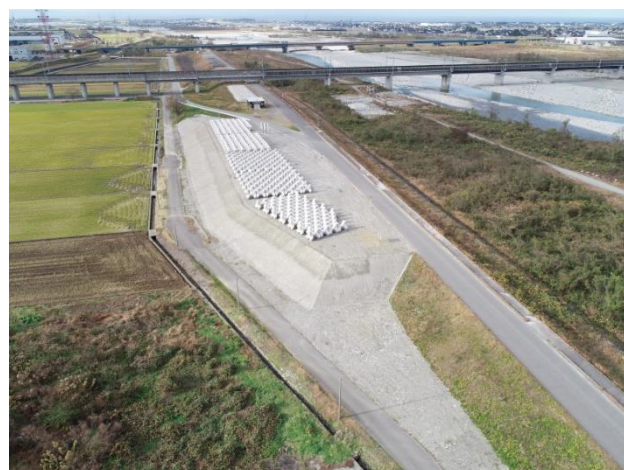
令和元年度黒部川備蓄ブロック製作他工事
