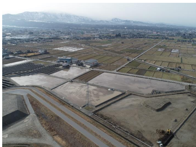
ほ場整備 出島地区11工区ほ場整備工事
