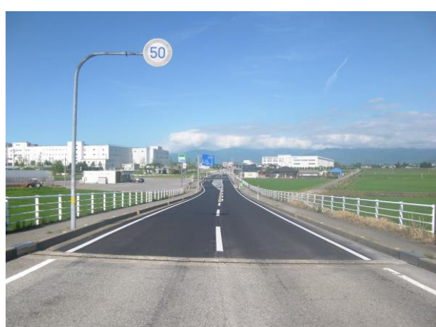
主要地方道若栗生地線道路総合交付金 (防災・災防・修繕) 舗装補修工事
