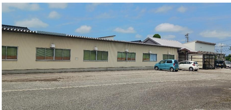
2029 年度中にコインランドリーを建設する予定の第 2 工場
