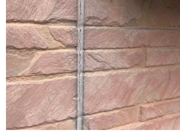
コーキング工事
