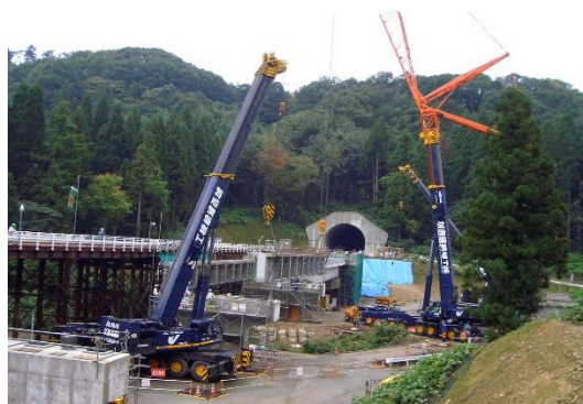
橋桁仮設工事
