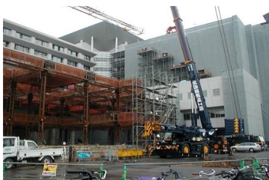
病院建設工事
