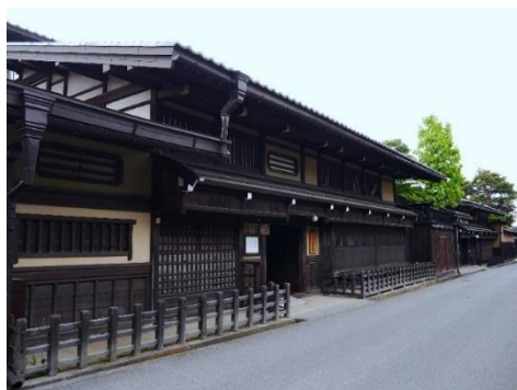
日下部家住宅（日本遺産構成文化財）改修工事
