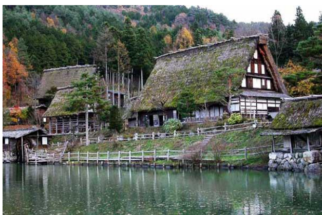
飛騨の里移築・復元工事
