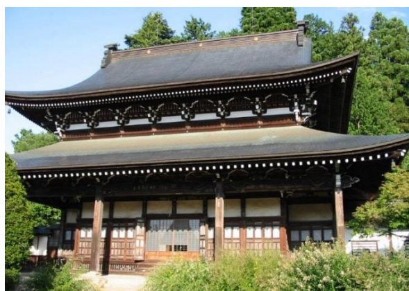
宗猶寺 庫裏建築工事（写真は本殿）
